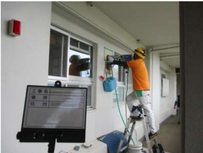
北側外壁への穴あけ
