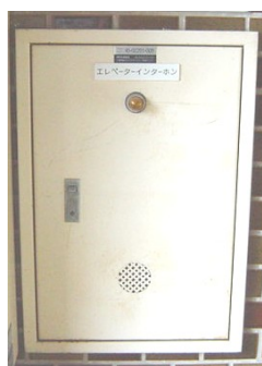
エレベーター インターホン
